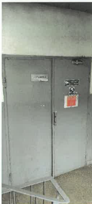
16. wejście korytarz fala kotłowni
