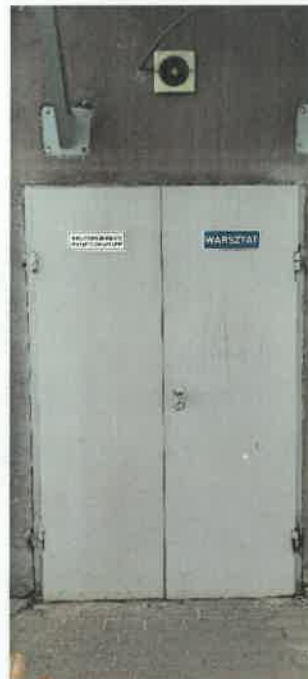
11. wejście warsztat wejście od kogeneracji
