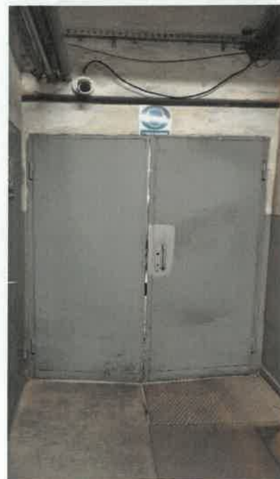
9. wejście do pompowni
