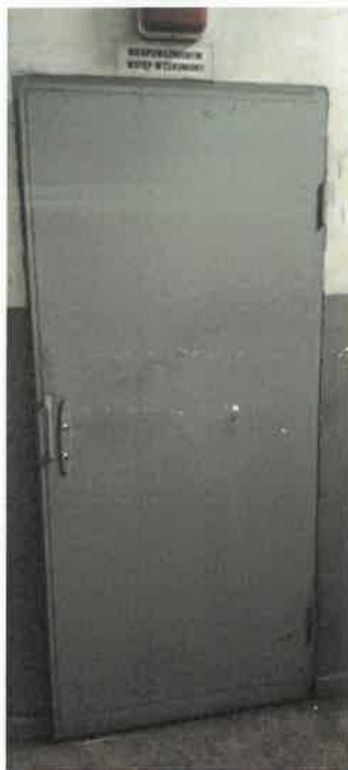
23. wejście hala kotłowa
