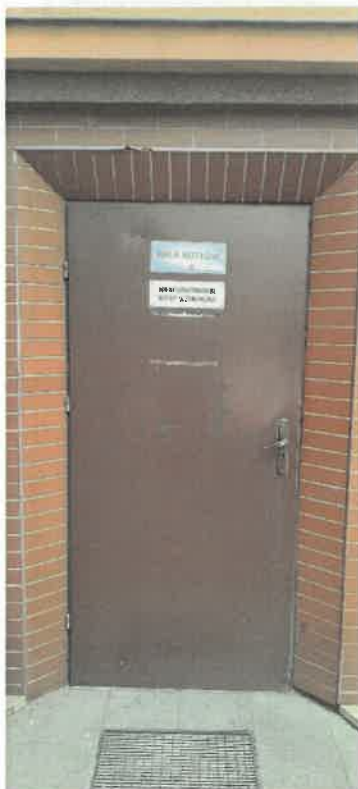
1. wejście główne do kotłowni
