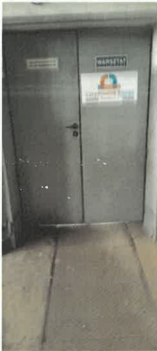
10. wejście warsztat (od pompowni)
