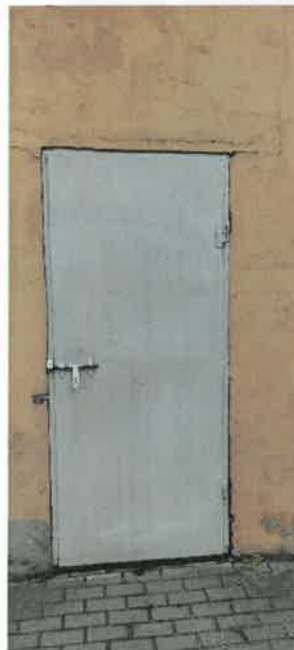
14. tunel odzużlanie (od kogeneracji)
